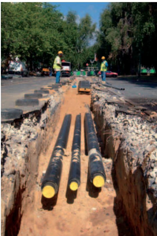
Un réseau de chaleur fonctionne en circuit fermé : il comprend toujours au moins deux canalisations, l'une pour distribuer la chaleur vers les utilisateurs, l'autre pour le retour du fluide refroidi vers les installations de production.
